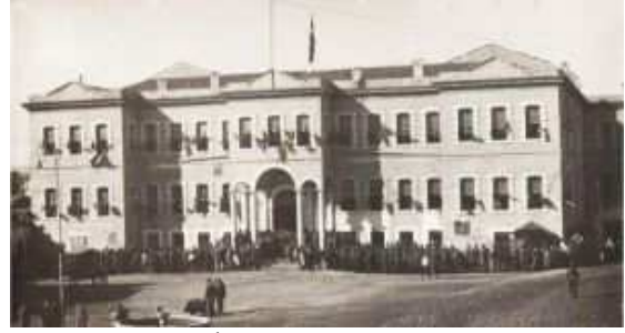
Foto. 14. Konya Hükümet Konağı
