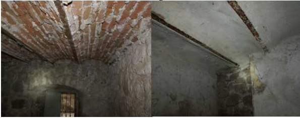
Foto. 3. Bergama Hükümet Konağı Metal Putrelli Volta Tonoz Türündeki Üst Döşemesi
