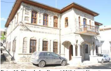
Foto. 18. Diyarbakır Ergani Hükümet Konağı
