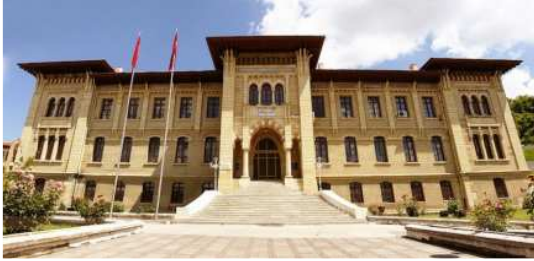
Foto. 20. Kastamonu Hükümet Konağı
