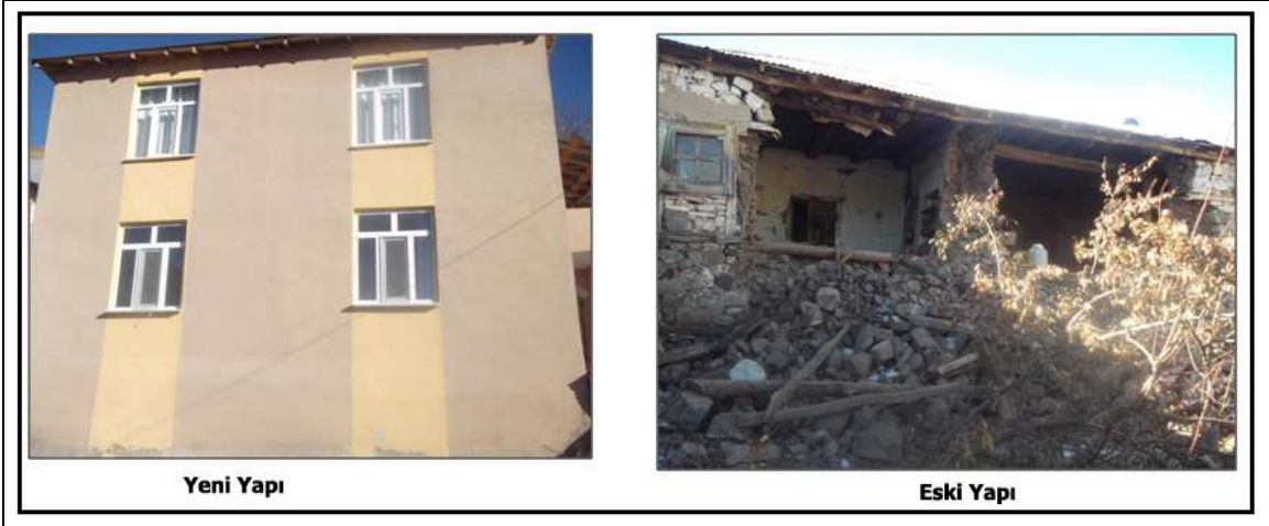
Foto 5. Yeni (Sabırtaş köyü) ve eski (Açıkgüney köyü) yapıların deprem sonrası durumu
