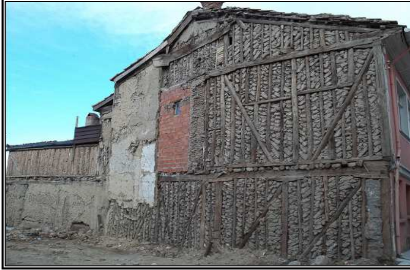
Fotoğraf 1: Hımış Tekniğı ile Yapılmış Bir Mesken.
