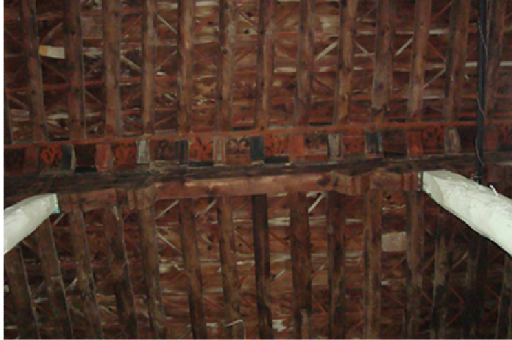
Fotoğraf No: 12 Üst Örtü. Onarım Sonrası
