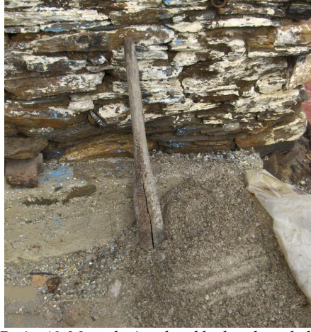
Resim 10. Mengelenin tokmakla dövülmüş hali.
