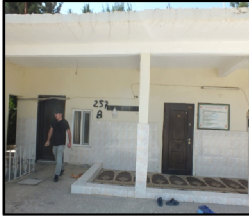
Şekil 7. Betonarme Camiinin Görünümü
