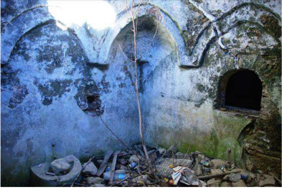
5.Fotoğraf: Akıncılar Köyü Hamamı, sıcaklık bölümünün genel görünüşü.
