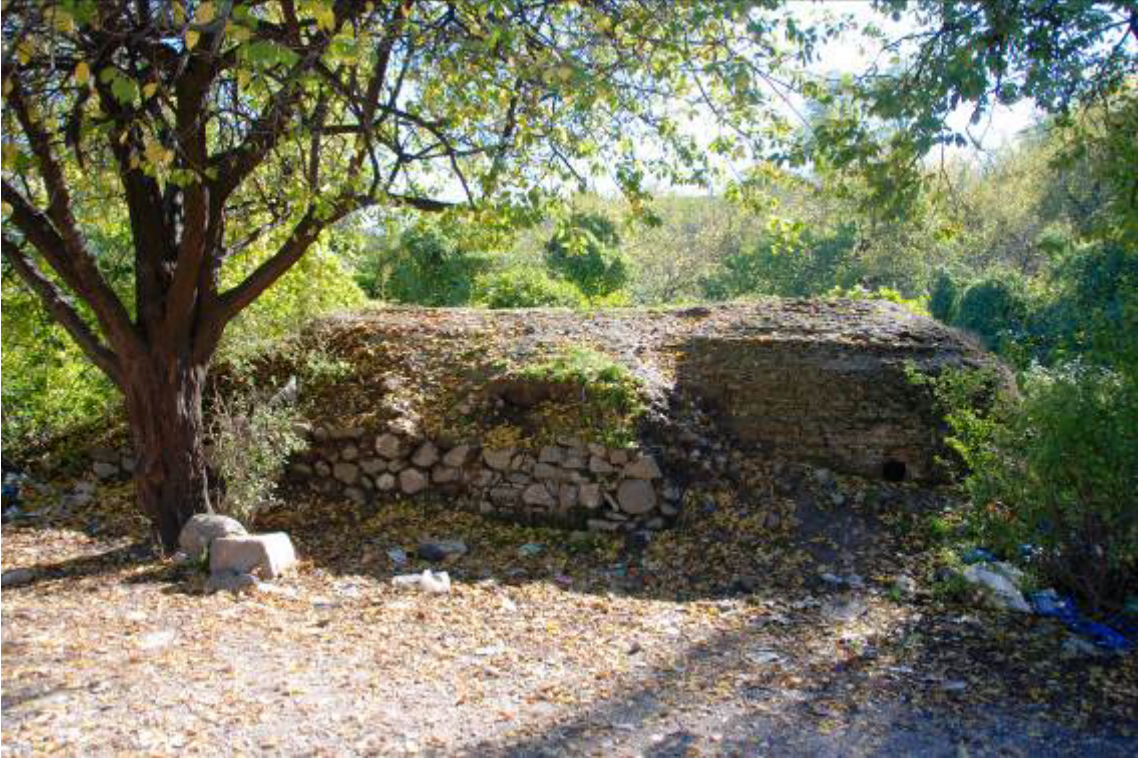
1.Fotoğraf: Akıncılar Köyü Hamamı, genel görünüşü.
