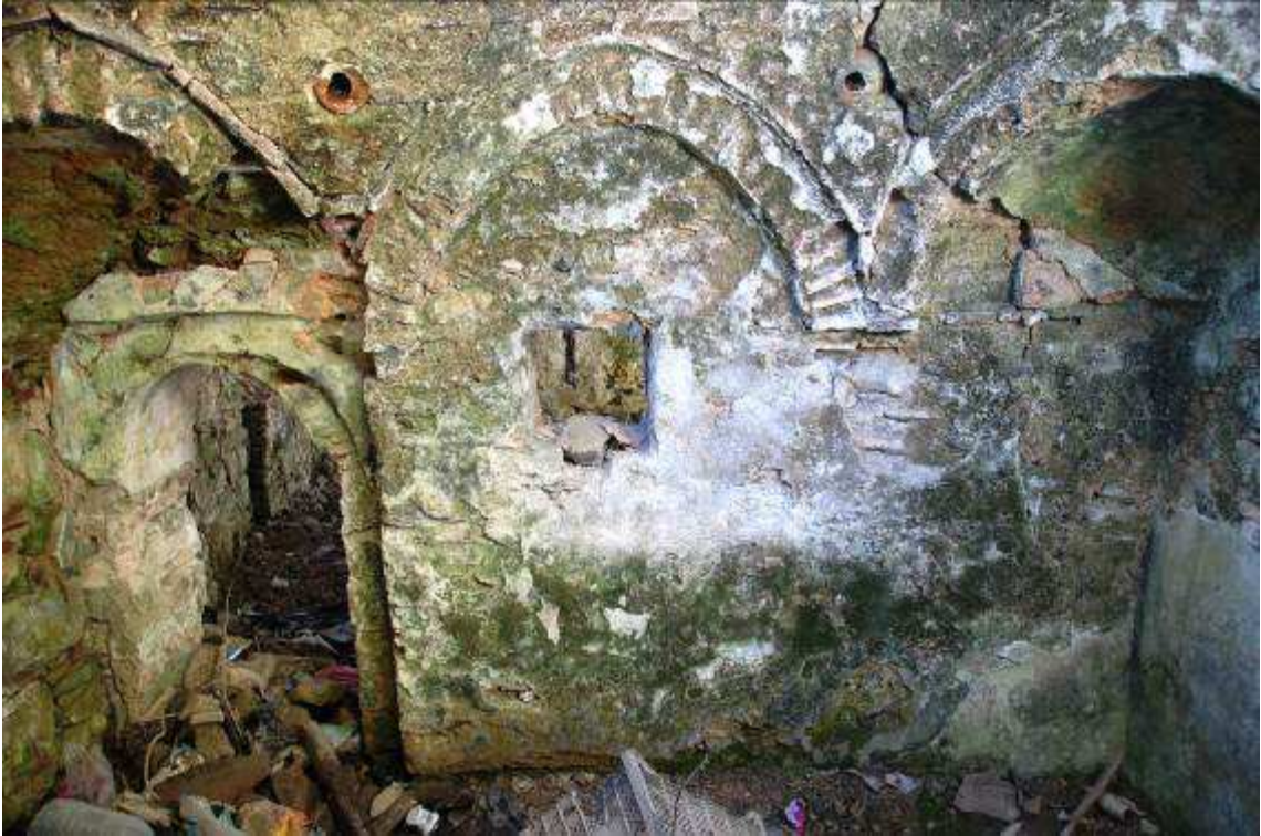
6.Fotoğraf: Akıncılar Köyü Hamamı, sıcaklıktan soyunmalığa bakış.
