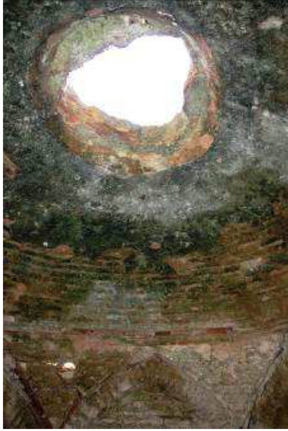
7.Fotoğraf: Akıncılar Köyü Hamamı, soyunmalık üst örtüsü ve aydınlatma sistemi.
