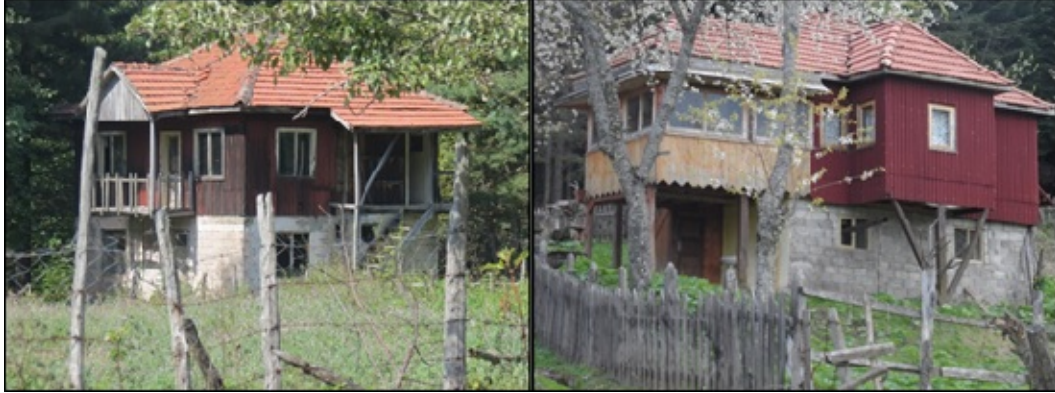
Fotoğraf 9. Sonradan yapılan evlerde bol miktarda pencere kullanılmış ve pencere ebatları da büyümüştür.
