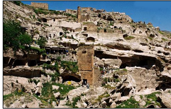
Foto 4 : Kale Kapıları ve kale yamacından bir görünüm.
