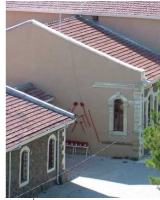
Foto. 12: İşletme Binası batı cephe
