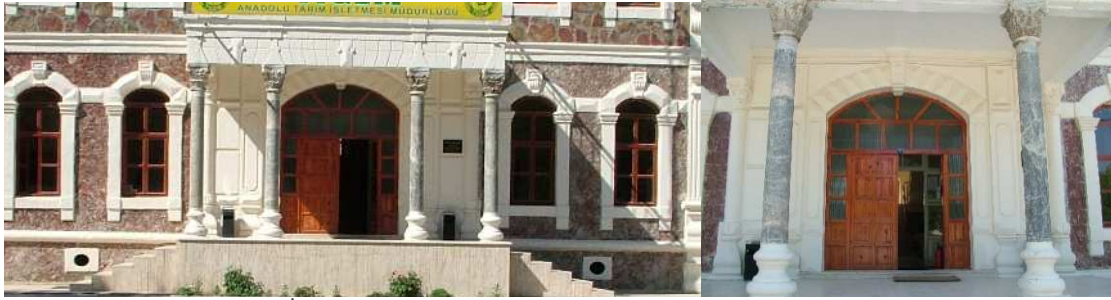
Foto. 8: Çifteler Harası İşletme Binası ana giriş
