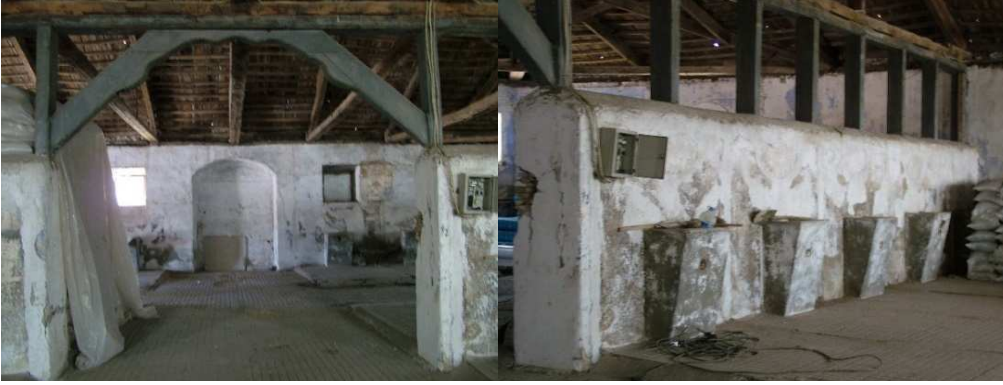
Foto. 17-18: Çifteler harası işletmesi depo B yapısı içten görünüş
