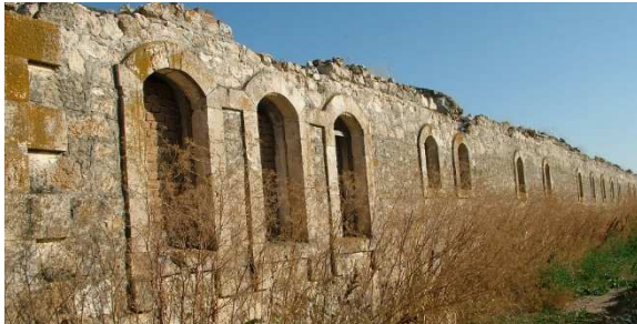
Foto. 23: İlk Hara binası yan cephe
