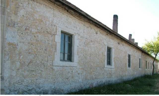
Foto. 14: Tarım İşletmesi depo A
