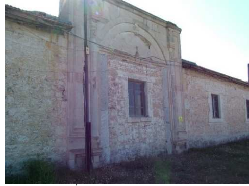
Foto.15: Tarım İşletmesi depo A eski girişi
