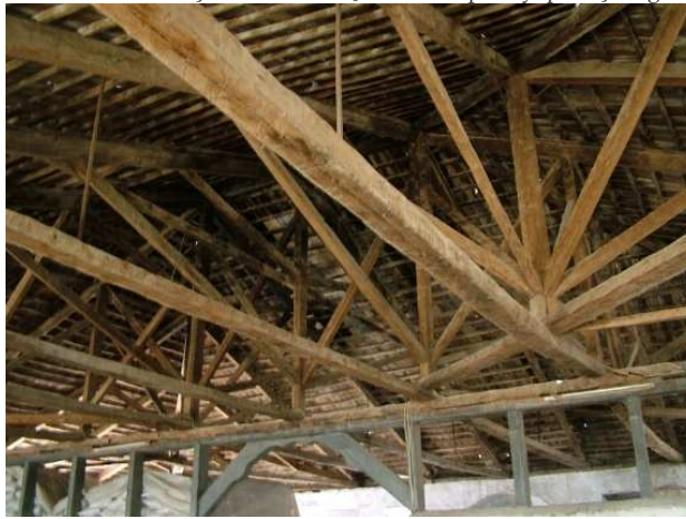
Foto. 19: Çifteler harası depo B binası çatı taşıma sistemi
