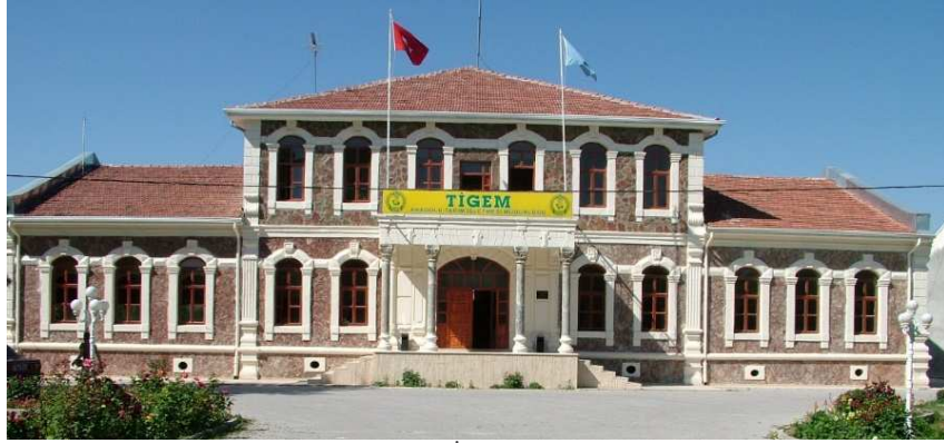
Foto. 3: Çifteler Harası İşletme Binası güney cephe
