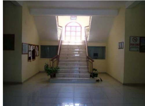
Foto.5: İşletme Binası üst kata çıkan merdiven
