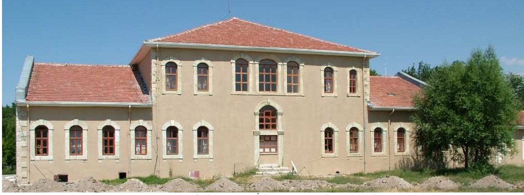
Foto. 10: Çifteler Harası İşletme Binası kuzey cephe
