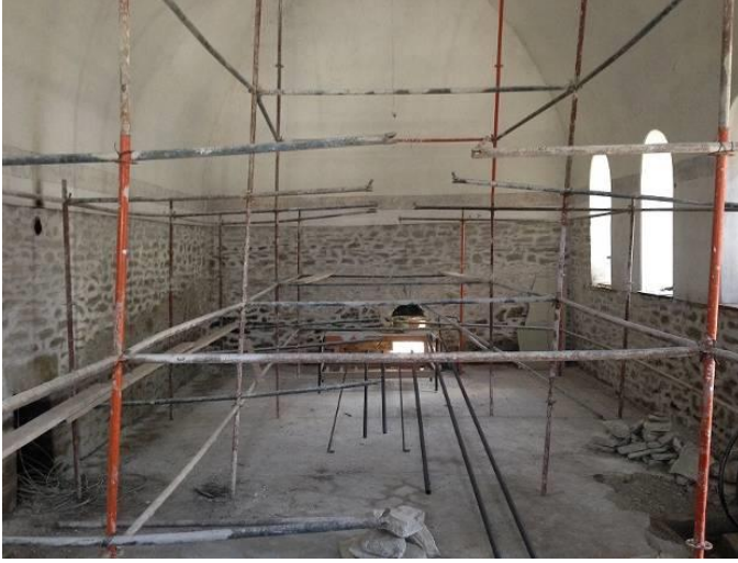
Foto. 25. Batı Duvar, Doğudan Batıya Bakış
