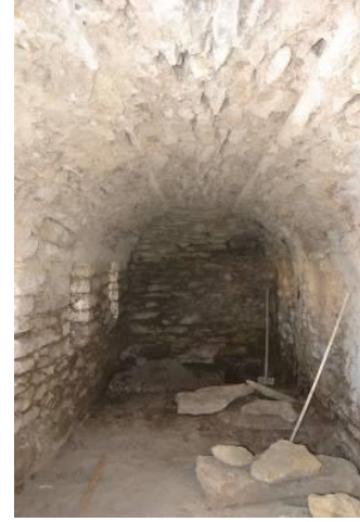
Foto. 31. Alt Kat, Kuzeyden Güneye Bakış
