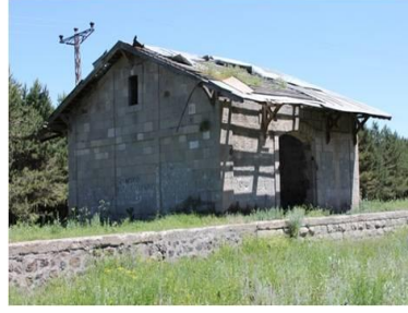
Resim 13: Ambar Binası (Benli Ahmet İstasyonu)
