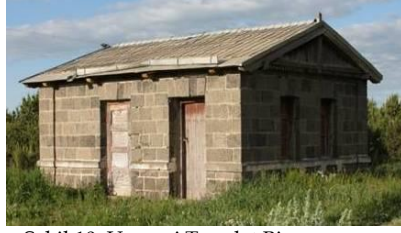
Şekil 10: Umumi Tuvalet Binası (Selim İstasyonu)
