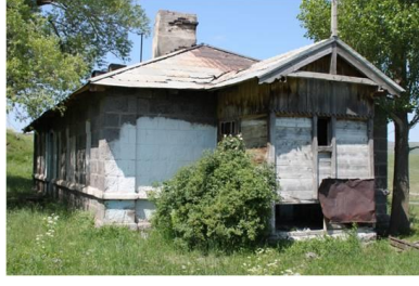
Resim 05: Çatak Köyü İstasyon Binası-Doğu Cephe
