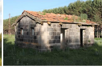
Resim 11: Umumi Tuvalet (Benli Ahmet İstasyonu)
