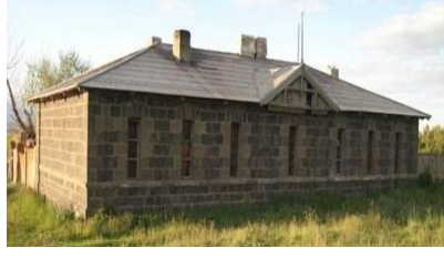
Resim 10: Selim İstasyonu Amele/Çavuş Binası
