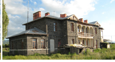
Resim 03: Selim İstasyon Binası (Arka Cephe)
