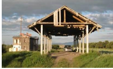
Resim 14: Açık Hangar (Selim İstasyonu)
