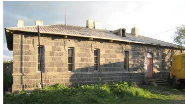
Resim 09: Selim İstasyonu Amele/Çavuş Binası
