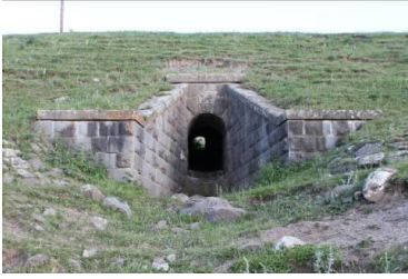
Resim 14: Selim-Çatak Arası 11 Nolu Menfez
