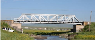
Resim 25: I Nolu Çelik Kafesli Köprü (Küllük Mevkii-Kars)
