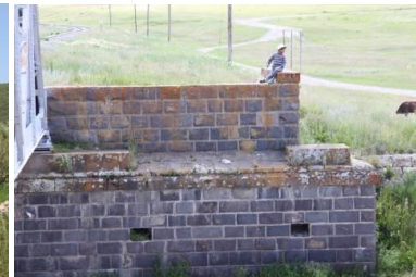
Resim 30: II Nolu Çelik Kafesli Köprü Ayak Yapısı (Dikme Köyü)
