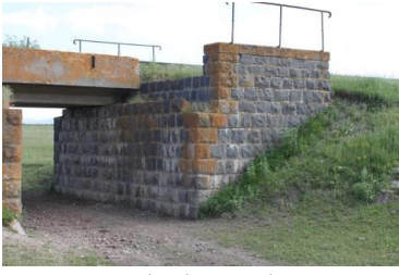
Resim 21: Benli Ahmet-Selim I Nolu Köprü Ayak Yapısı
