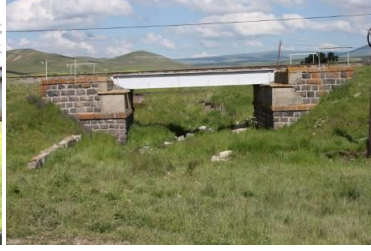
Resim 24: Kars-Benli Ahmet V Nolu Demir Kirişli Köprü
