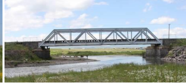
Resim 26: II Nolu Çelik Kafesli Köprü (Dikme Köyü)
