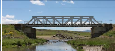
Resim 28: IV Nolu Çelik Kafesli Köprü (Selim-Eğrice)
