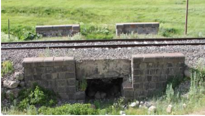
Resim 03: Menfezli Demiryolu Yapısı
