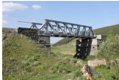
Resim 29: V Nolu Çelik Kafesli Köprü (Sarıkamış)
