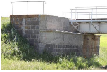
Resim 23: Kars-Benli Ahmet IV Nolu Demir Kirişli Köprü Ayak Yapısı
