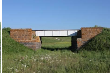
Resim 22: Kars-Benli Ahmet III Nolu Demir Kirişli Köprü
