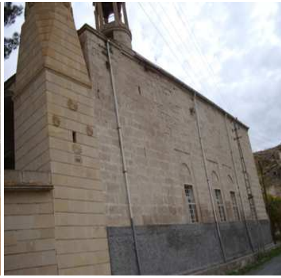
Fotoğraf 6 : Cami Batı Cephesi
