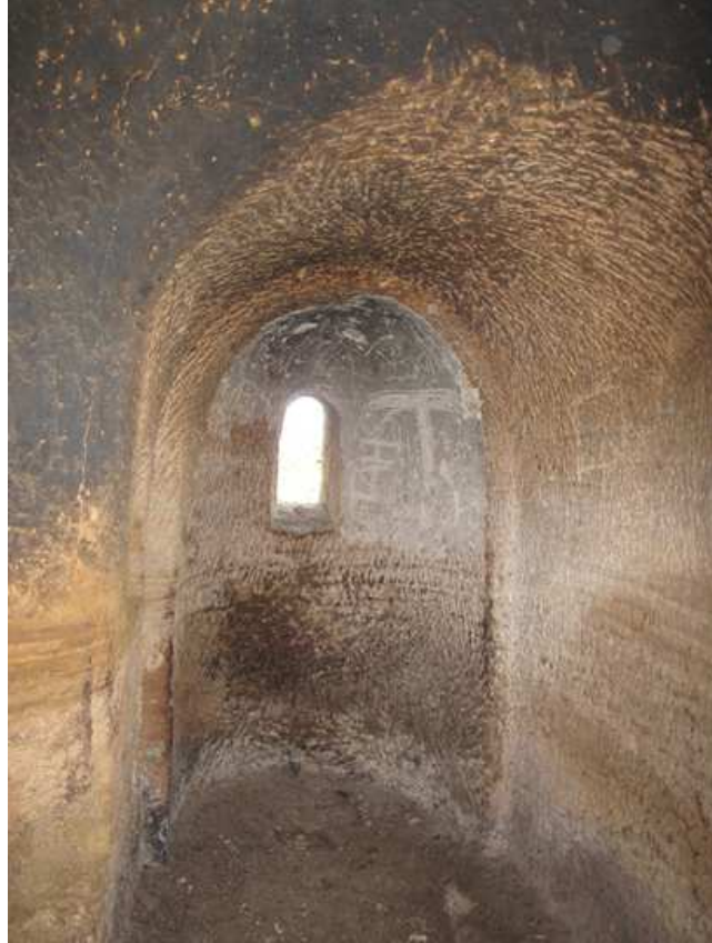
Resim 3: 1. Kat Üst Tonoz Örtü ve Sıva Parçaları.
