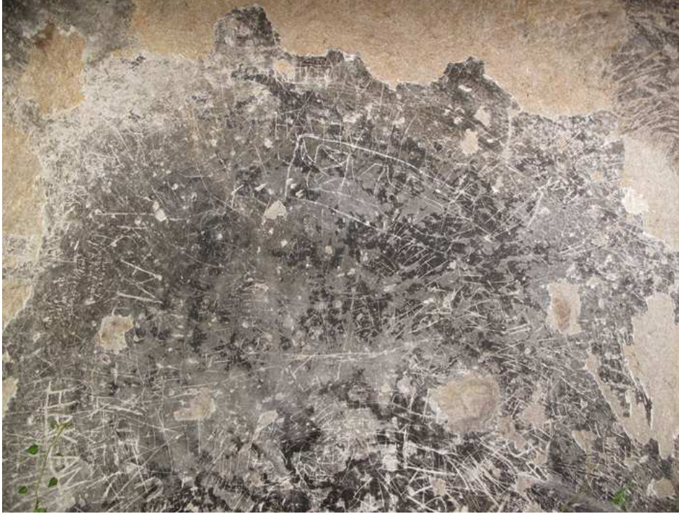
Resim 6: 1. Kat, 2. Kısım Üst Örtüdeki Sıva İzleri
