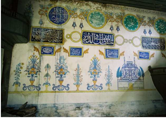
Resim 09: Gültepe Köyü-Yukarı Kefeli Mah. Camii Kalemîşi Bezeme-Doğu Duvarı (Onarım Öncesi)
