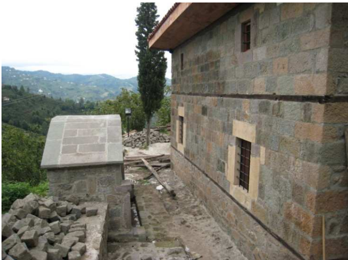
Resim 07: Gültepe Köyü-Yukarı Kefeli Mah. Camii Güney Cephe ve Şadırvan
