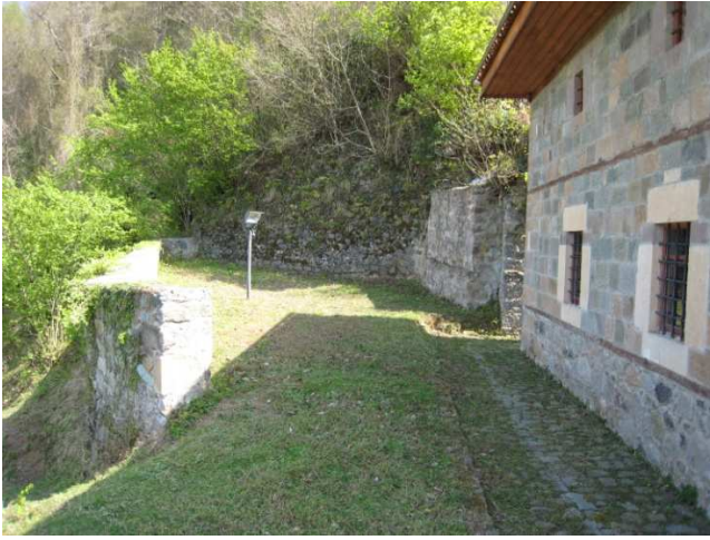
Resim 30: Medrese Yeri (Onarım Sonrası, 2014)
