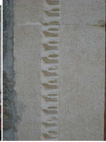
Resim 35: Kapı Sövesi-Bezeme Unsuru
