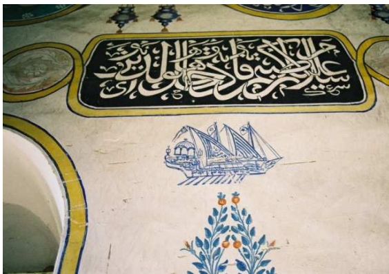
Resim 19: Duvar Süslemeleri-Gemi Tasviri (Onarım Öncesi)
