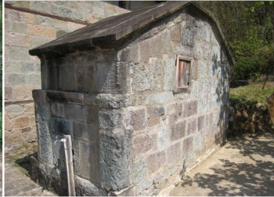
Resim 29: Şadırvan Güney- ve Batı Cephesi (Onarım Sonrası, 2014)
