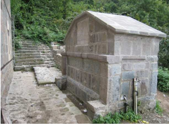
Resim 28: Şadırvan Kuzey- ve Batı Cephesi (Onarım Sonrası, 2006)
