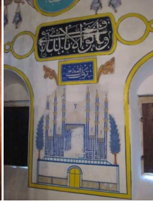
Resim 17: Duvar Süslemeleri (Onarım Sırası)
