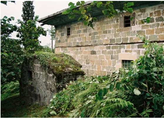
Resim 05: Gültepe Köyü-Yukarı Kefeli Mah. Camii Güney Cephesi (Onarım Öncesi, 2005)
