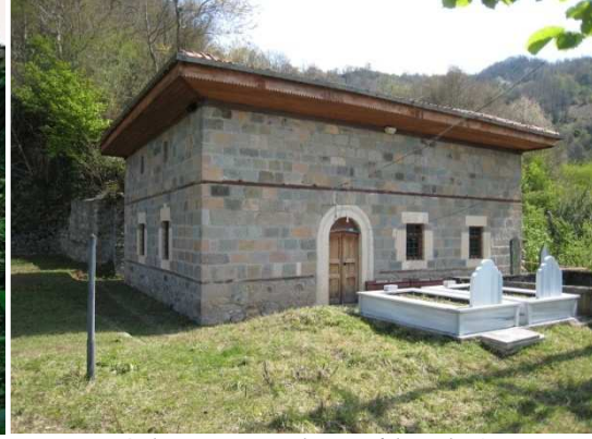
Resim 04 : Gültepe Köyü-Yukarı Kefeli Mah. Camii Kuzey- ve Batı Cephesi (Onarım Sonrası, 2014)
