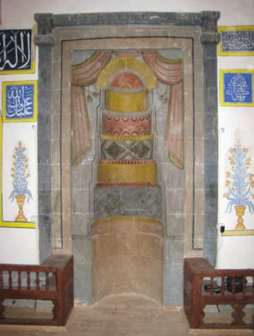
Resim 13: Mihrap (Onarım Sonrası)
