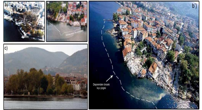
Foto 4: Değirmendere'de Deprem Sonucunda Meydana Gelen Kıyı Heyelanıyla Kıyı Çizgisinin Değişimi a) Depremden Önceki Kıyı Çizgisi (1996) b ve b') Deprem Sonucunda Çökmeler ve Kıyı Heyelanıyla Oluşan Kıyı Çizgisi c) Günümüzdeki Kıyı Çizgisi
