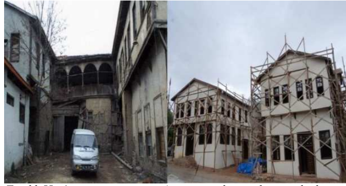
Foto. 1. Taraklı Han'ın restorasyon öncesi ve sonrası kuzey-doğu cepheden görünümü
