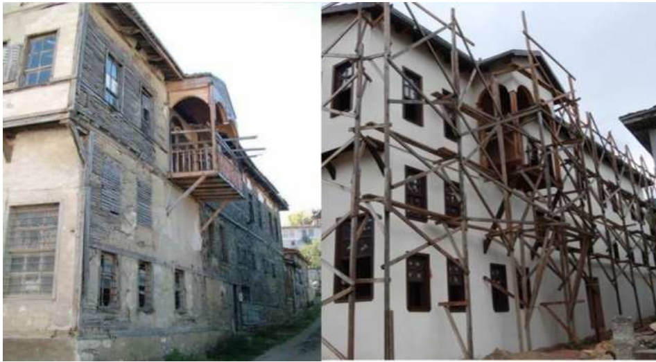
Foto. 5. Taraklı Han'ın batı cephesinin restorasyon öncesi ve sonrası görünümü
