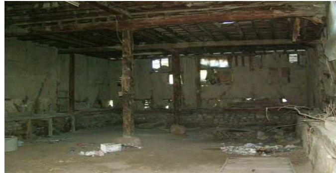
Foto. 3. Taraklı Han'ın zemin kat ahır bölümünün restorasyon öncesi görünümü
