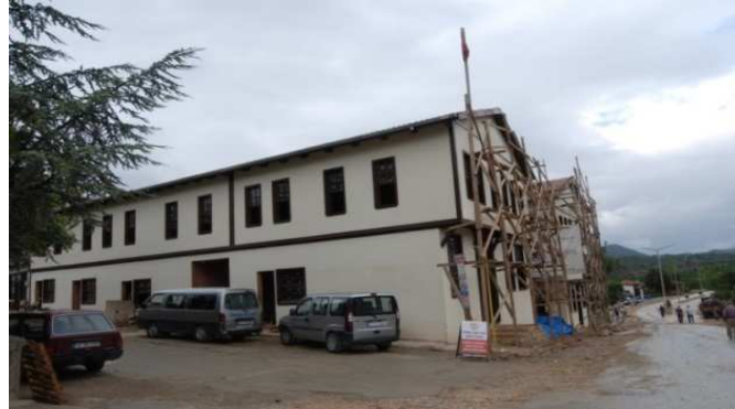
Foto. 2. Taraklı Han'ın restorasyon sonrası doğu kanadının görünümü
