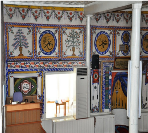
Foto.25:Emine Hanım Cami Kible Duvarı Kalemışleri
