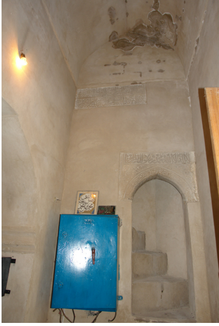
Res. 8. Tuba Şah Mescidi, çatıya çıkış kapısı ve merdiveni
