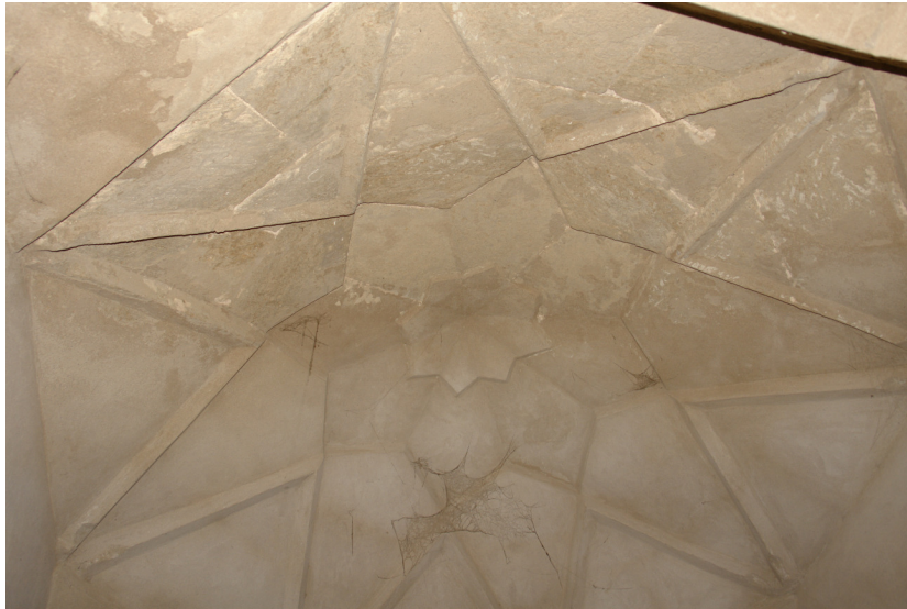
Res. 7. Tuba Şah Mescidi, güneydoğu köşe mekânının tonoz örtüsü
