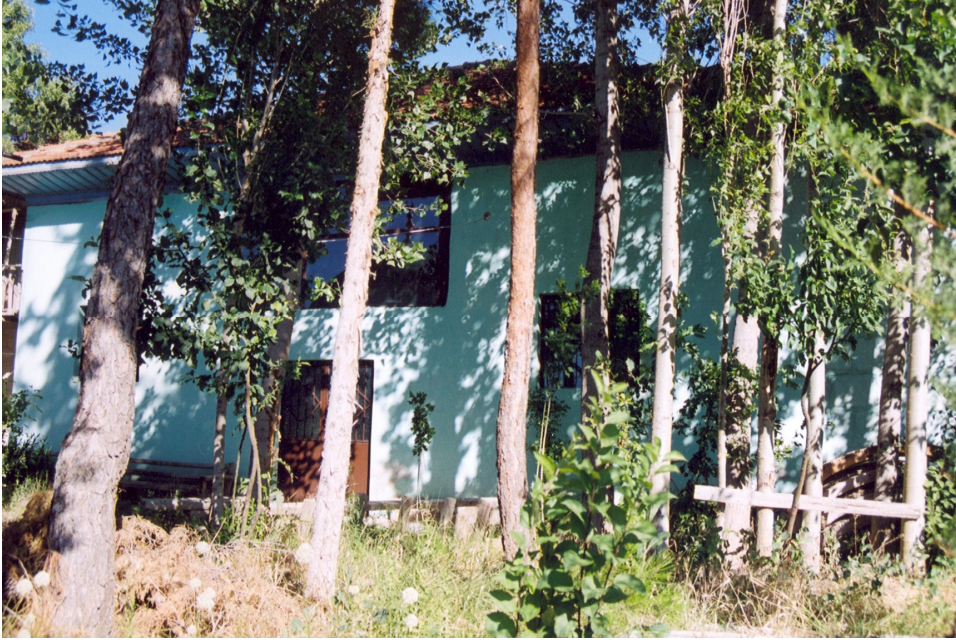
Fotoğraf 48: Sarıkavak Köyü Camii, doğu cepheden görünüş
