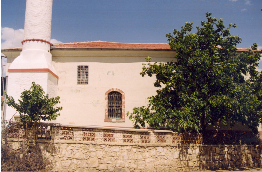
Fotoğraf 38: Söğüt Köyü Merkez Camiinin genel görünüşü
