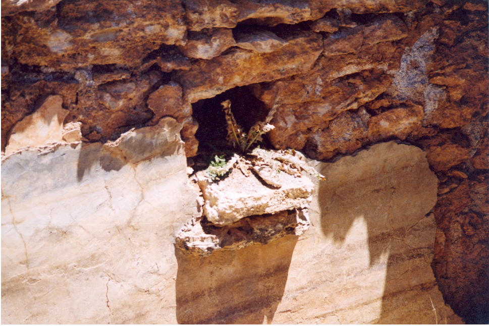
Fotoğraf 30: Gemiş Köyü, II. Sarnıcın duvarlarından ayrıntı
