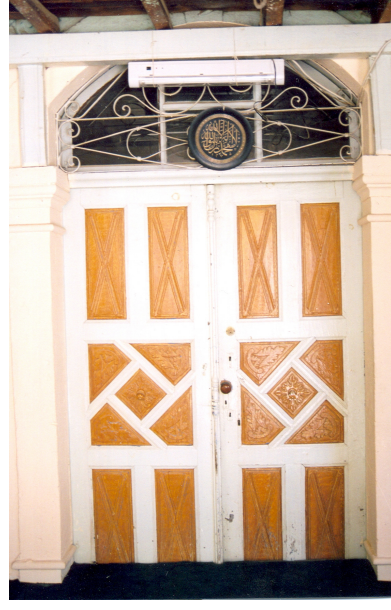
Fotoğraf 41: Söğüt Köyü Merkez Camii, giriş kapısı
