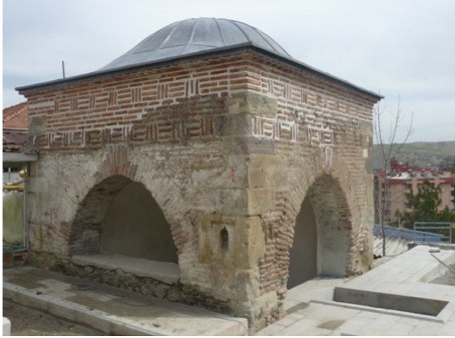
Res.8: Havza İmaret Türbesi Onarım Sonu (2009)
