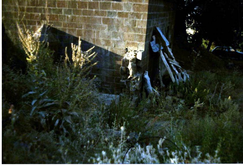
Foto 10: Haydar Bey Camii Güneydoğu Köşe Duvar Kalıntısı
