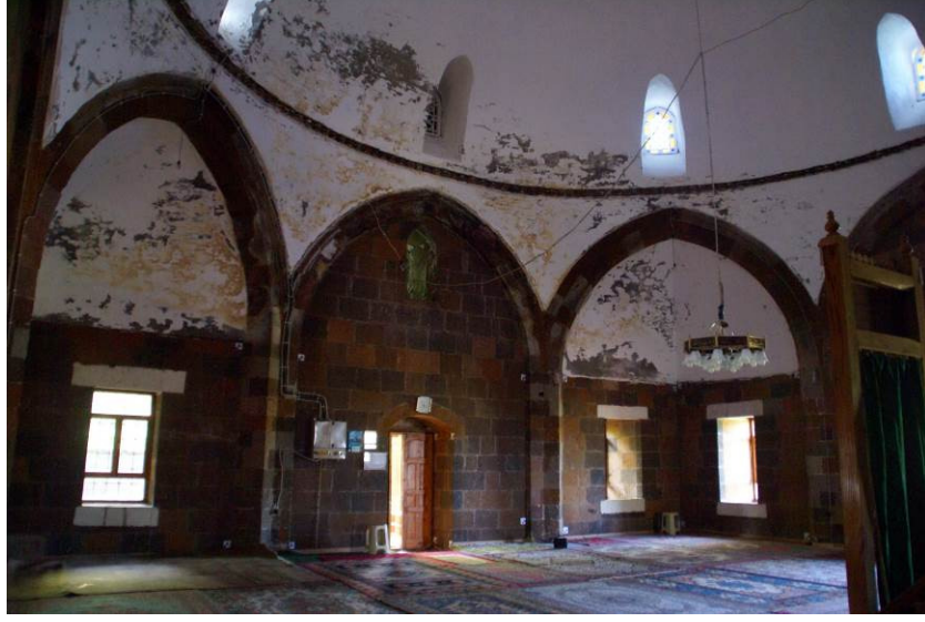
Foto 20: Ahlat İskender Paşa Camii Geçiş Sistemi
