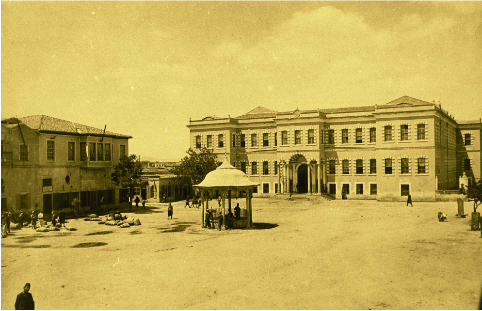
5- Konya Vilayet Binası
