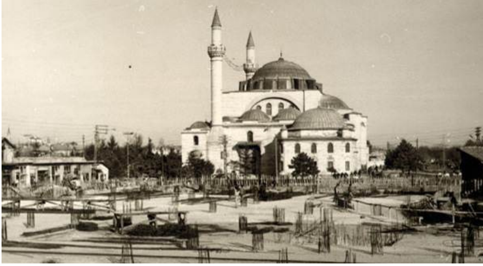
Fotoğraf 2. Türbeönünde yapılan Mevlana Çarşısının temellerinin görünüşü
