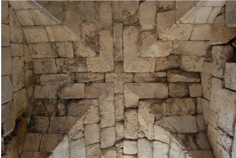
Fotoğraf-7. "E" Muhafız Odasındaki Çapraz Tonoz Örtü Sistemi
