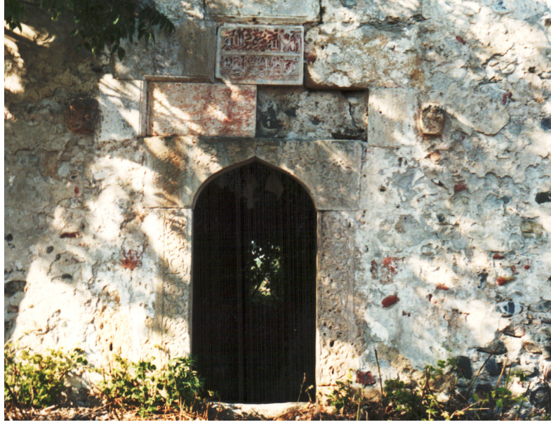
Bafra / Türbe Köyü - Emirza Bey Türbesi, kapı ve çevresi
