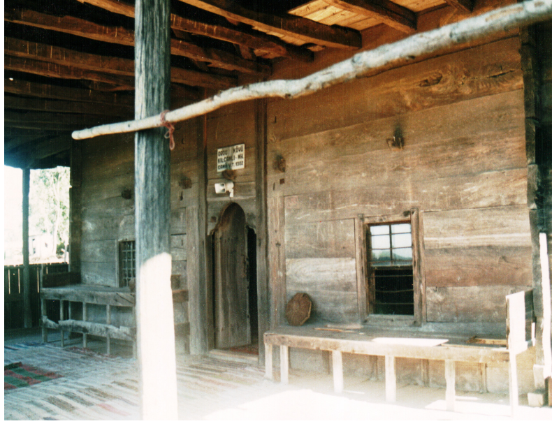
Çarşamba / Ordu Köyü Camii, harimin kuzey duvarı
