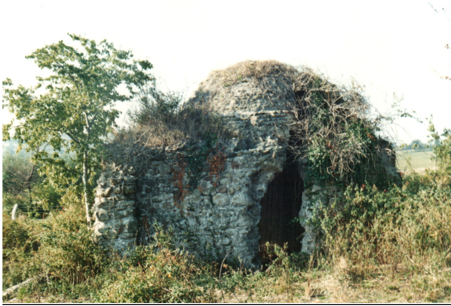
Bafra / Çetinkaya Beldesi - Hızır Bey Hamamı, kuzey cephe
