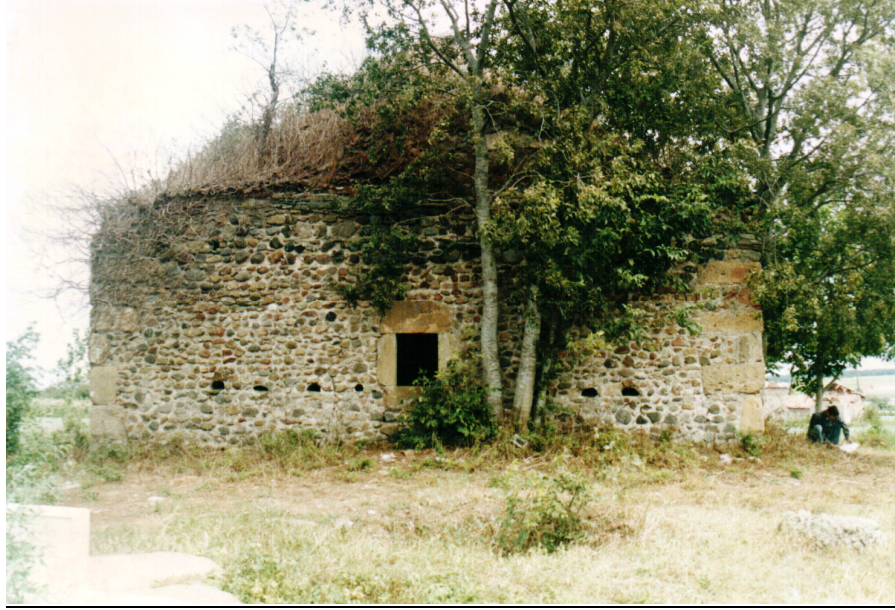
Bafra / Türbe Köyü - Emirza Bey Türbesi, batı cephesi
