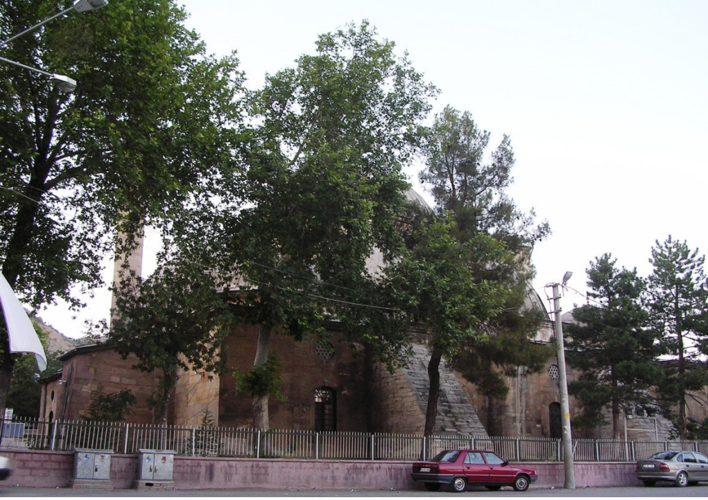
Resim 5: Çankırı Ulu Camii'nin Güney Cephesi
