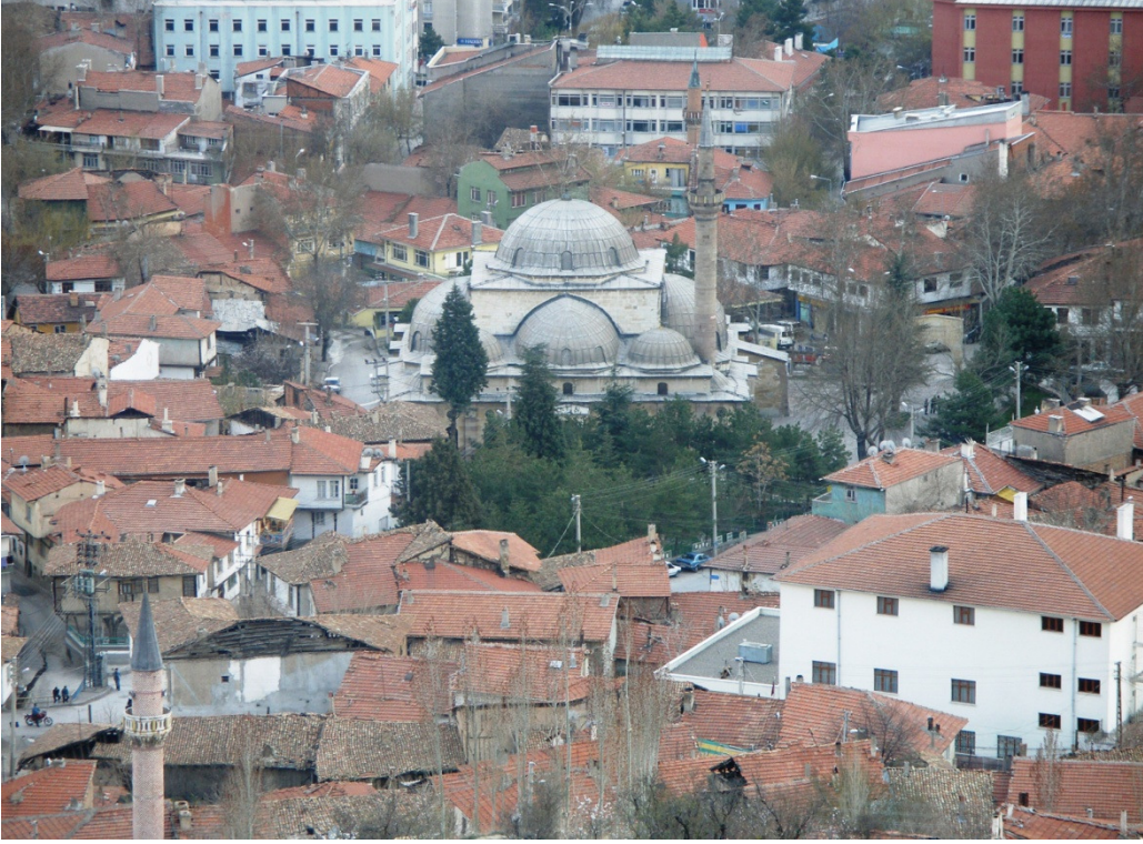
Resim 1: Çankırı Ulu Camii'nin Genel Görünüşü
