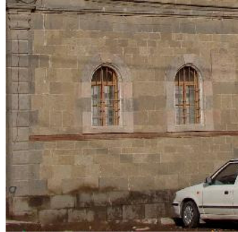
Resim 34: Cephedeki Yarım Yuvarlak Kemerli Pencereleler
