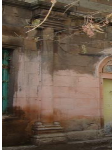
Resim 28: Giriş Kapısının Yanındaki Sütunce
