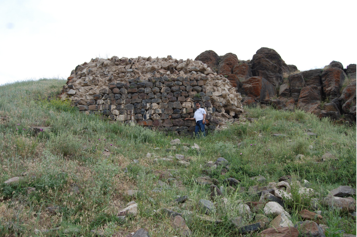
Fotoğraf 7: Kalenin batı sur duvarı kalıntısı
