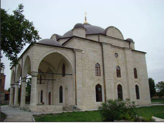
Resim 11: Bulgaristan, Hasköy Uzuncaova'daki Sinan Paşa Camii. (Foto: B. Güray, 2008).
