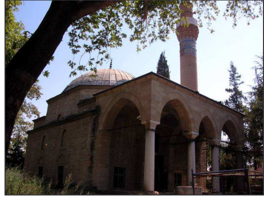
Resim 6: Bursa, Yenişehir Sinan Paşa Camii. (Foto: N. Yazıcı, 2007).
