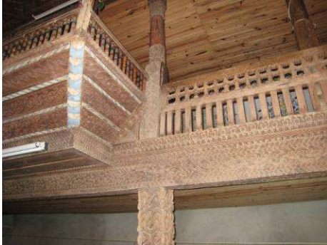
Foto 42: Araklı-Turnalı Köyü Camii- Mahfil
