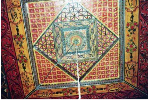
Foto 40: Dernekpazarı-Akköse Köyü Camii Tavan Göbeği
