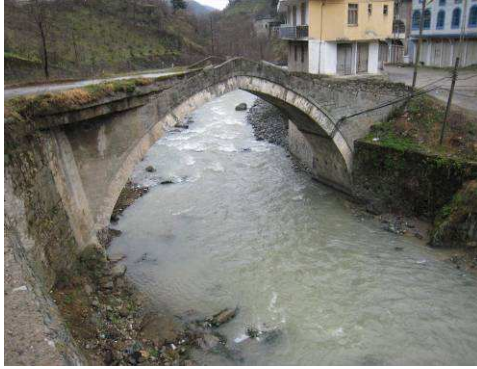
Foto 42: Bifara Köprüsü Memba Cephesi
