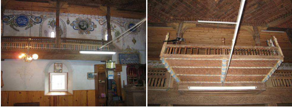
Foto 10: Os (Turnalı) Köyü Camii Doğu Duvarı Foto 11: Os (Turnalı) Köyü Camii Müezzin Köşkü
