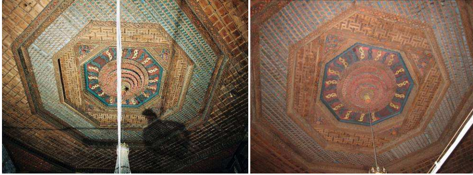
Foto 14: Os (Turnalı) Köyü Camii Tavan Foto 15: Os (Turnalı) Köyü Camii Tavan Göbeği Süslemesi
