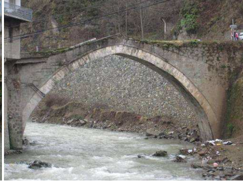
Foto 43: Bifara Köprüsü Mansap Cephesi
