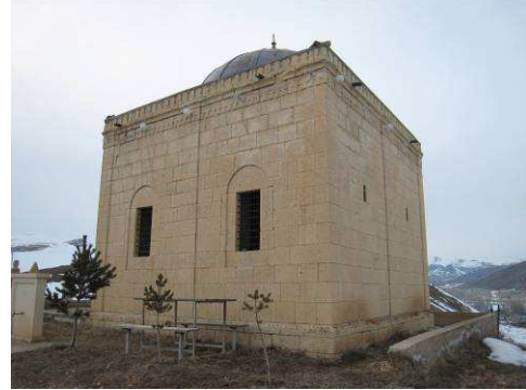
Foto 57: Akşar-Oslu Hoca Türbesi Güney Cephesi
