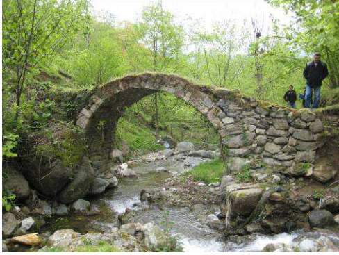
Foto 44: Dağbaşı Yolu İrnak Köprüsü Membra Cephesi
