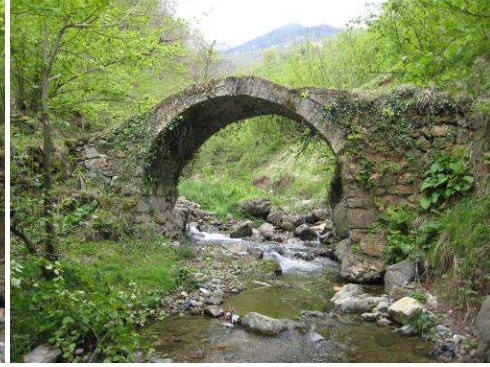
Foto 45: Dağbaşı Yolu İrnak Köprüsü Mansap Cephesi
