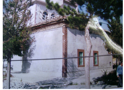
10- Havza / Dereköy - Veliyyüddin Bin Bereket Şah Camii ve Türbesi, güney ve batı kible cepheler.
