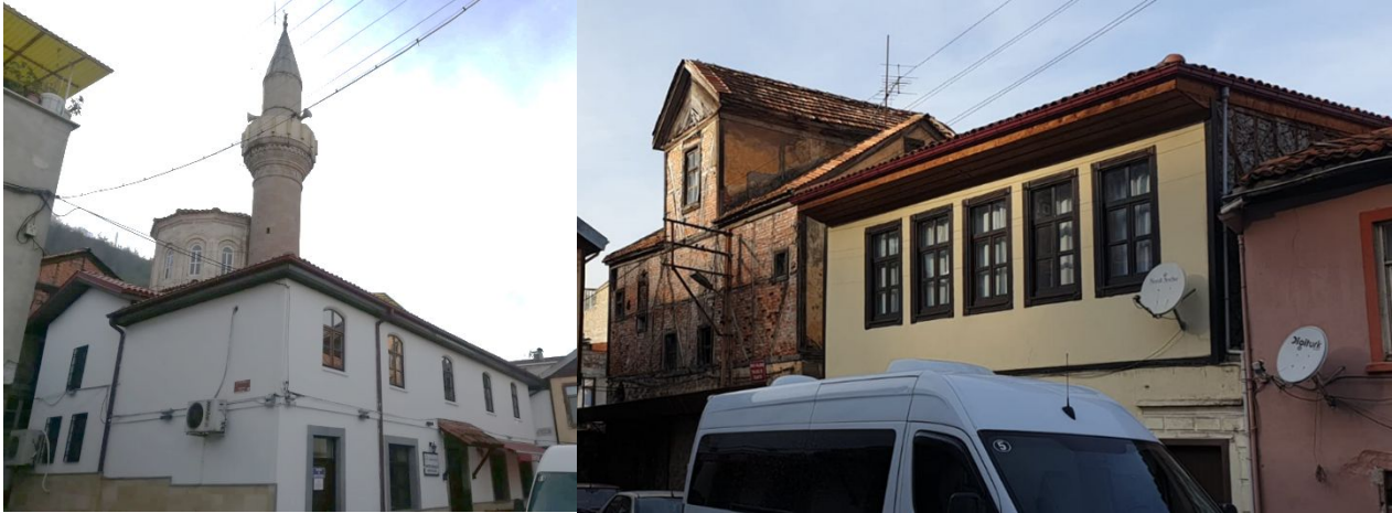
Şekil 4: Kudrettin Cami ve restore edilen binalar
