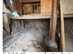
Şekil 9: 15 numaralı gümelelerin zemin katı ve asma katı (2019).
