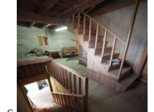
Şekil 11: İki oda ortasından ulaşım sağlayan merdiven konumu (2019).
