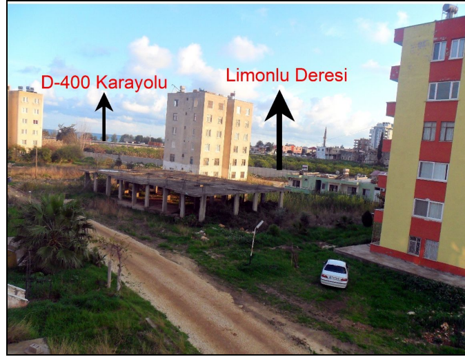
Şekil 12. Limonlu Deresi'nin aşağı çıkışında yer alan beton bent ve etrafındaki yerleşmeler
