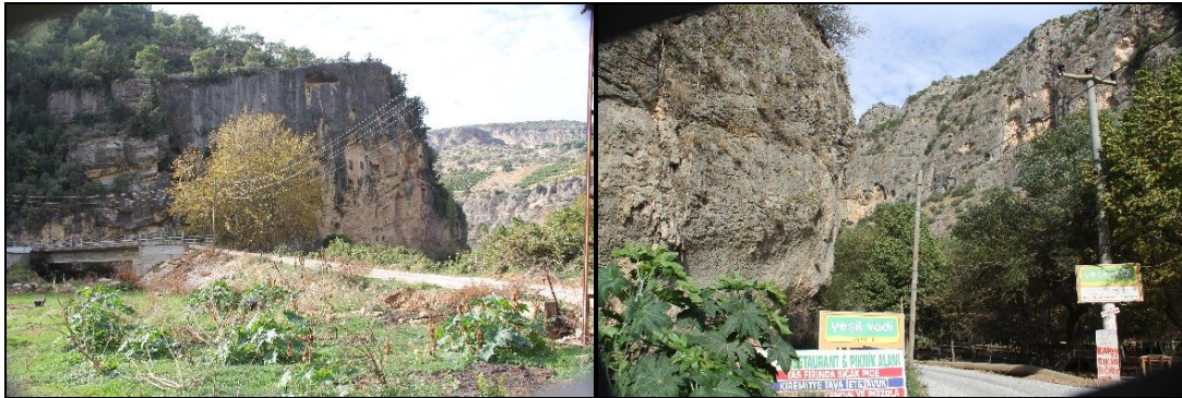
Şekil 10. Limonlu Deresi'nin aşağı çığırında yer alan ve yayla yolu olarak kullanılan güzergâhtaki köprü (solda) ve dere yatağında kanyon girişinde yer alan piknik sahaları
