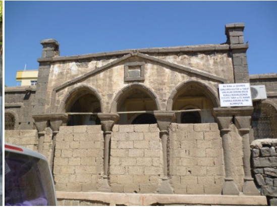
Resim 8: Köranlı Konağı Üçgen Alınlık
