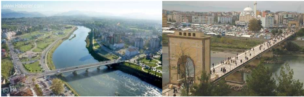
Şekil 13: Çarşamba İlçesi'ndeki Yeşilirmak ve Köprüsü
