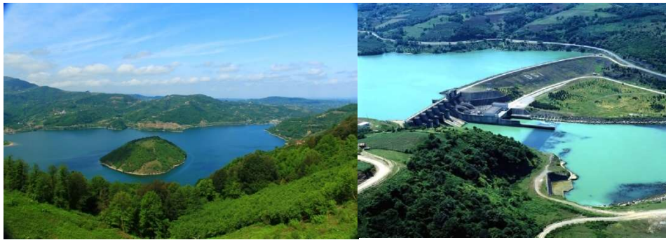
Şekil 8: Ayvacık İlçesi'ndeki Baraj Gölü ve Suat Uğurlu Barajı
