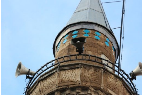
Şekil 32: Camii minaresinin külahın altındaki petek kısmına uygulanan çini bezemeden bir görünüm (Bayrak Kaya, 2018)
