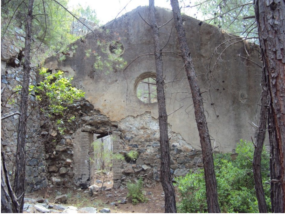
Şekil 9. Yapı kompleksi içerisindeki depo yapısının yan cephesi (Kaynak:Antalya Koruma Bölge Kurulu Müdürlüğü Arşivi)
