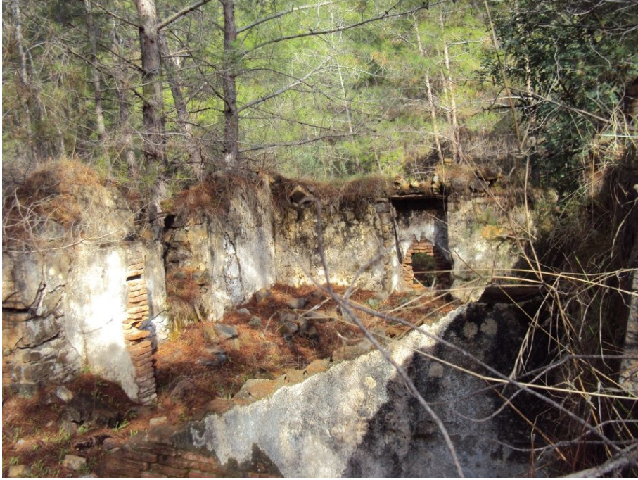
Şekil 10. Yapı kompleksi içerisindeki konut yapısının içten görünümü (Kaynak:Antalya Koruma Bölge Kurulu Müdürlüğü Arşivi)
