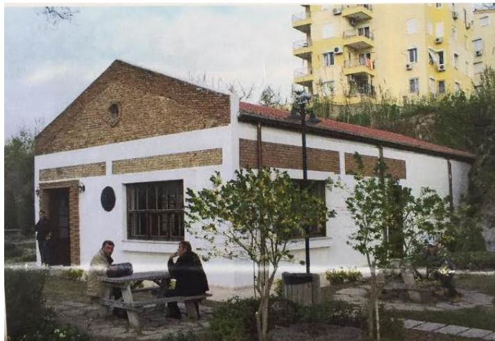
Şekil 2 Değirmenönü Caddesindeki restorasyonu yapılan un değirmeni (Kaynak: Antalya Koruma Bölge Kurulu Müdürlüğü Arşivi)
