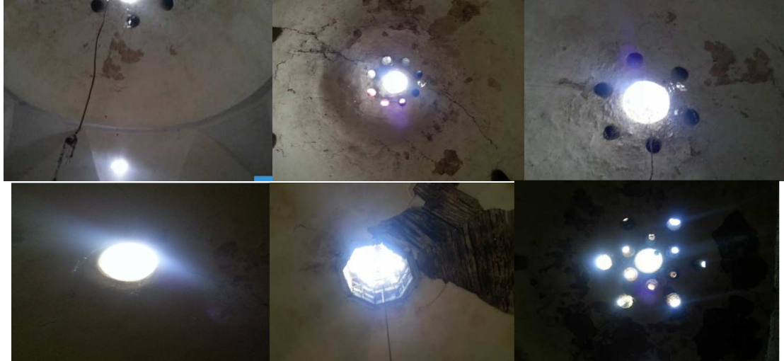
Resim 8: Mustafa Ağa Hamamı farklı mekânlardan alınmış iç mekân ışıklıkları, soğukluk mekânı çatısında bulunan ahşap aydınlatma feneri (Genç arşivi, 2016)
