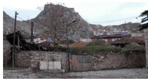
Resim 2: Hamam genel görünüşü; Güney Cephesi (Genç arşivi 2016)
