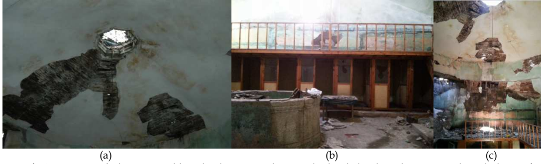
Resim 11. Mustafa Ağa Hamamı'nda soyunmalık mekânlarını çevreleyen yüksekçe kalın duvarların üzerinde aydınlatma feneri (a) - (b), soyunmalık mekânlarını çevreleyen soyunmalık kabinleri (c) (Genç arşivi 2016)
