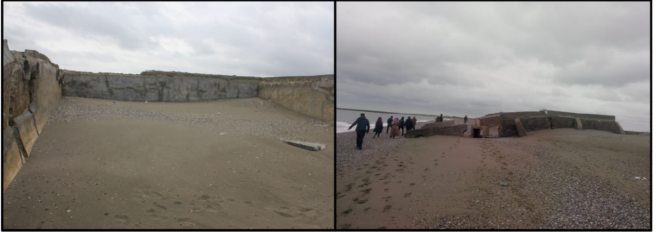
Şekil 6. Kıyı gerilemesiyle deniz ve kumullar tarafından yutulmuş yapının kalıntıları (Bafra, Fener Mah.).
