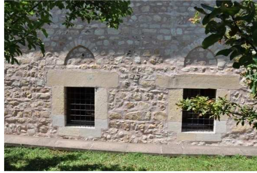
Şekil 6. Candaroğlu Mahmut Bey Camii Doğu Cephesi Alt Kat Pencereleri
