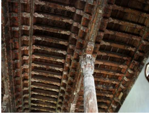
Şekil 14. Ahşap Dikme ve Tavan Kirişi Birleşimi
