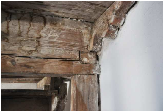
Şekil 19. Mahfil Döşeme Kirişi ve Dikme Birleşim Detayı
