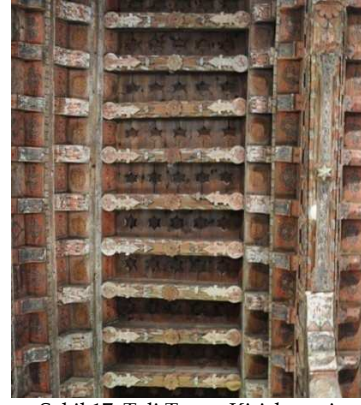
Şekil 17. Tali Tavan Kirişlemesi
