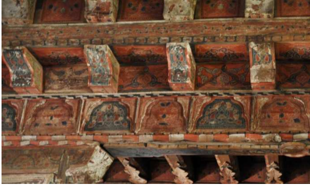
Şekil 16. Ahşap Bindirmeler
